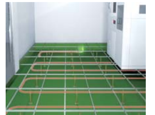
フリーアクセス下にセンサを取り付け
