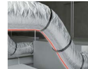
配管にセンサを取り付け
