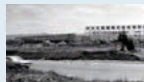
建設中の福知山工場
