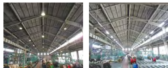
写真は高効率照明器具への取替前(左)および取替後(右)の状況です。
