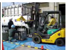
PCB廃棄物の排出風景
