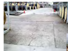
路面の改良工事
