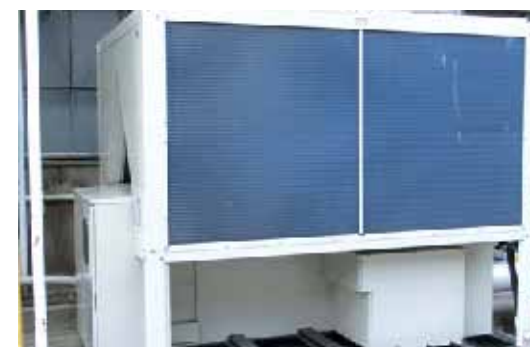
◇上は、大阪地区で設備更新時に水冷式から空冷式に変換した冷却用のチラーです。また、運転方法も冬季は既設のクーリングタワーを活用するなどして節電に努めた結果、電力量で約53kWの削減、原油換算で約13klの削減となる省エネとなりました。
