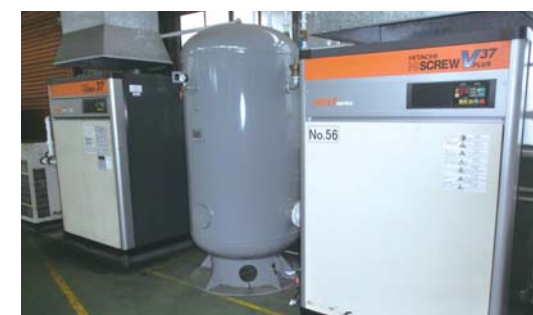
◇上は、大阪地区で設備更新時に導入した、インバーター式コンプレッサー(右手前)です。 また、設備更新と同時に、写真左奥のコンプレッサーと組み合わせ、基礎負荷機と変動負荷吸収機役割を与え、変動負荷吸収機を作業負荷に応じて稼働させる省電力運転を実施したことにより、電力消費量を導入前の約51%に抑えられ、1年あたり約51kl(原油換算)削減することができました。
