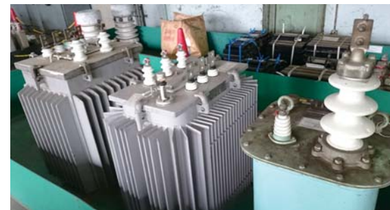
◇廃PCB機器などの保管状況
