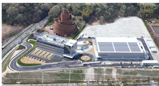
タツタテクニカルセンター
