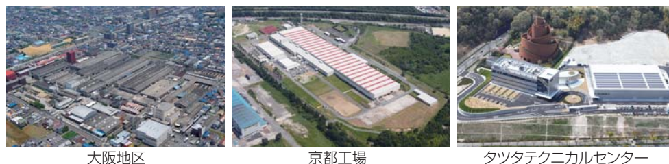
大阪地区 京都工場 タツタテクニカルセンター
