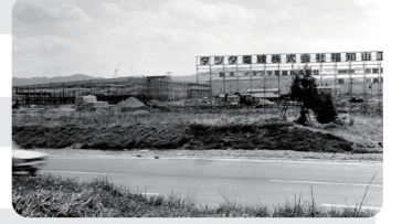
建設中の福知山工場(現 京都工場)
