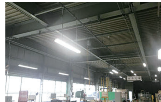
保全作業室 LED 照明更新
