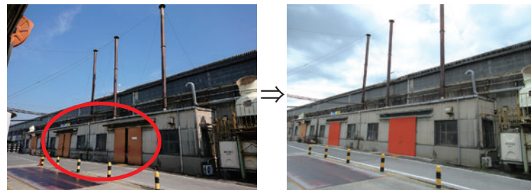
騒音対策としてボイラー室扉の改修事例
