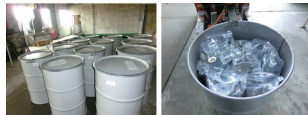
PCBの保管状況
