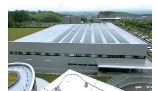
タツタテクニカルセンターの工場棟に設置した太陽光発電モジュール
