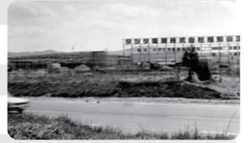
建設中の福知山工場(現 京都工場)
