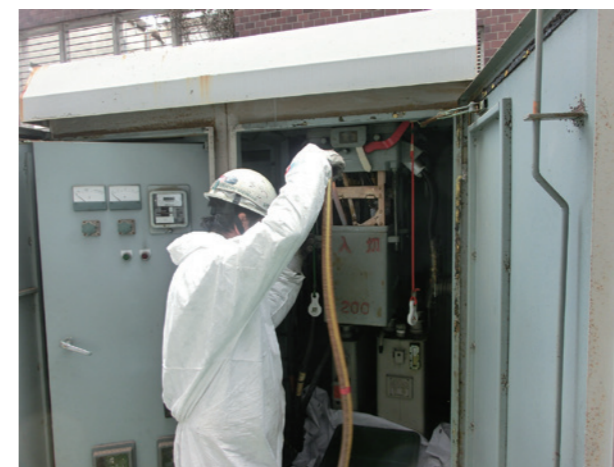
微量 PCB 汚染絶縁油の排出風景
